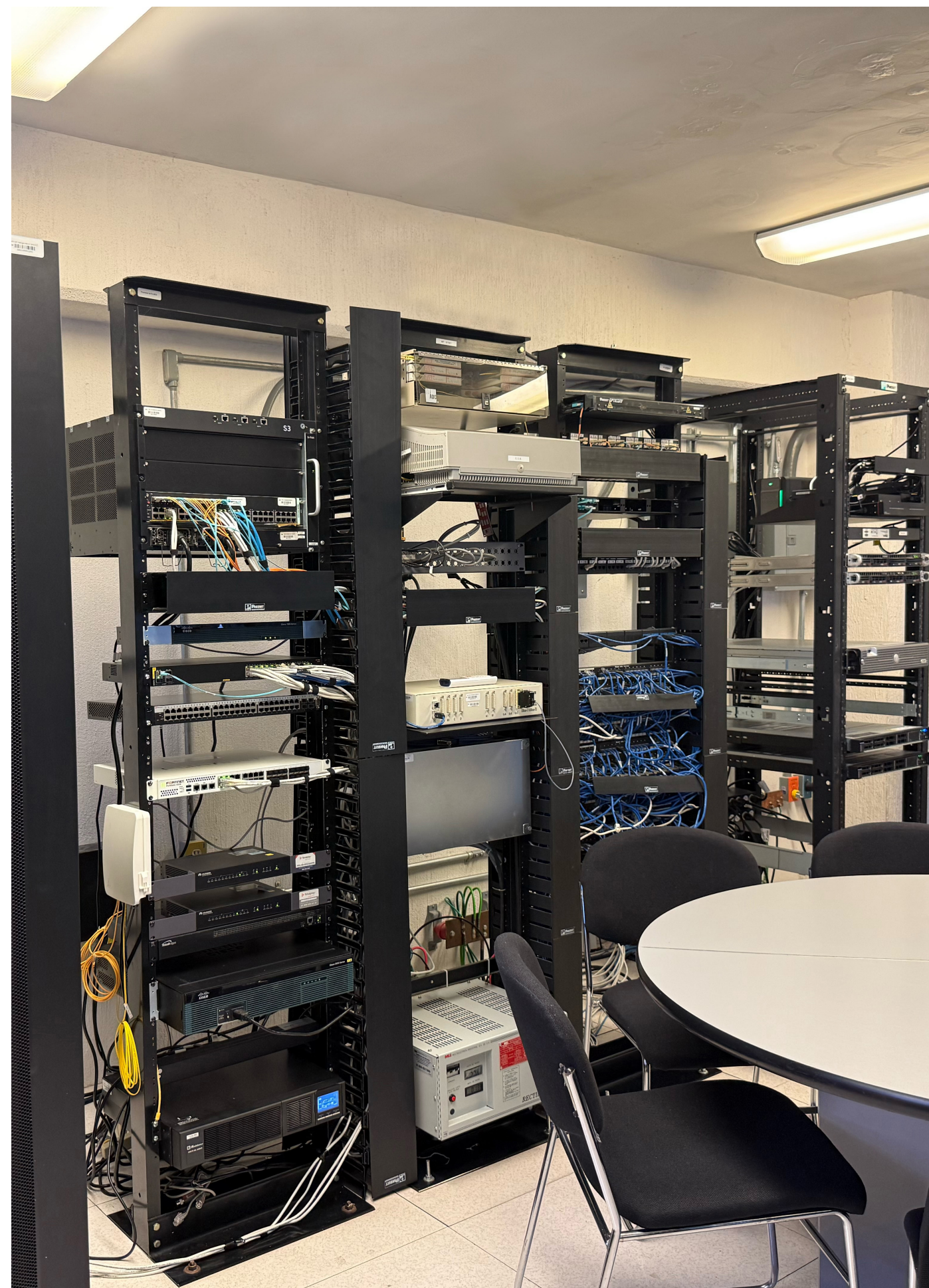
Site de comunicaciones: Centro de control de la red (backbone), enlace a Internet (routers), troncales telefónicas, conmutador y servidores de alto desempeño.
