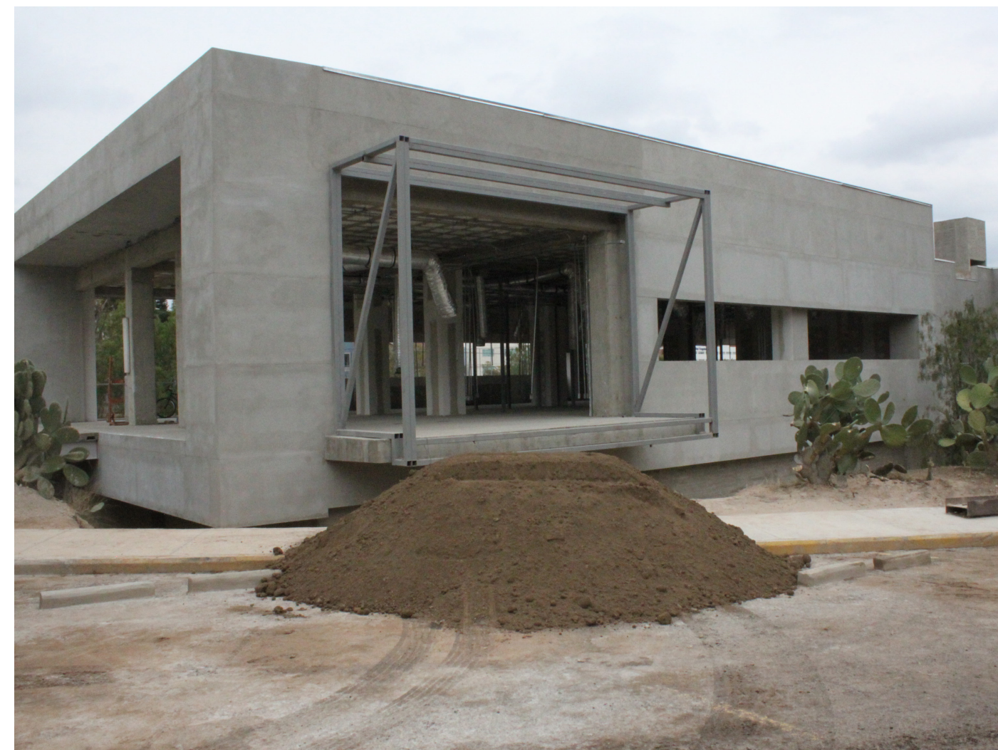
Obra negra del edificio H del CIO.
