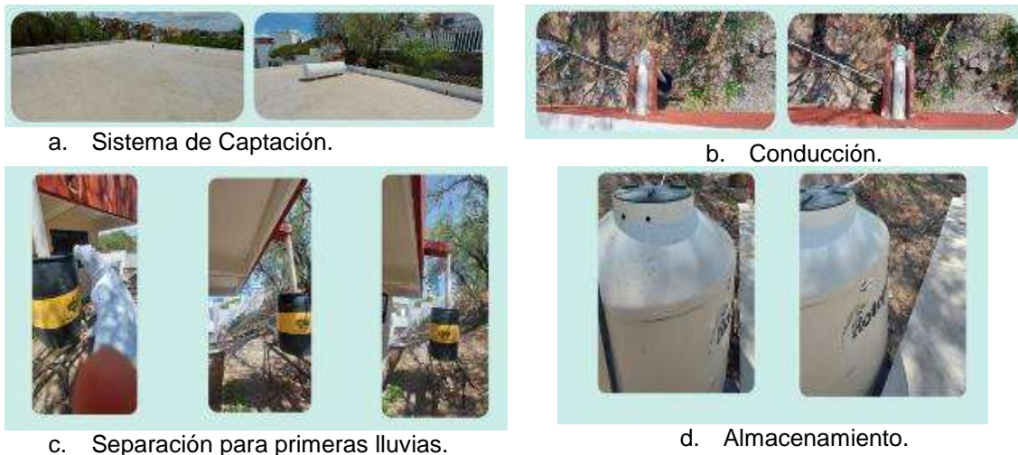
Figura 1. Partes de un Sistema de Captación de Agua de Lluvia implementado en la ENMSGTO.
