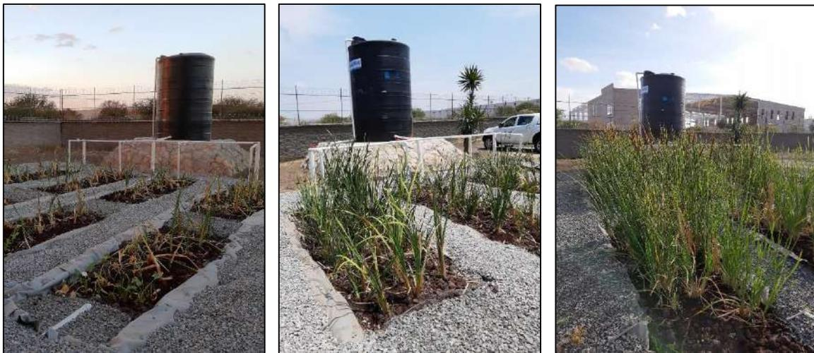
Figura 4. Adaptación del sistema de humedales construidos para depuración de agua proveniente del río Turbio por un periodo de 5 meses.
