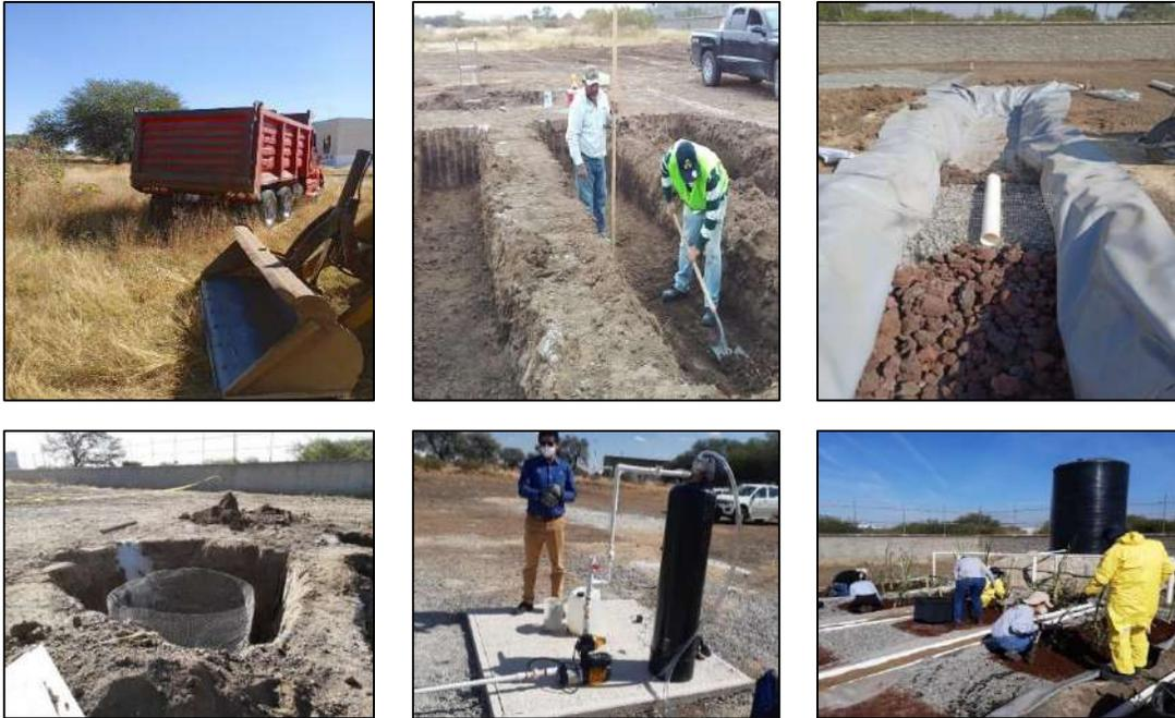
Figura 3. Construcción de sistema de tratamiento de agua proveniente del río Turbio a base de humedales construidos y sistema de bioadsorción.
