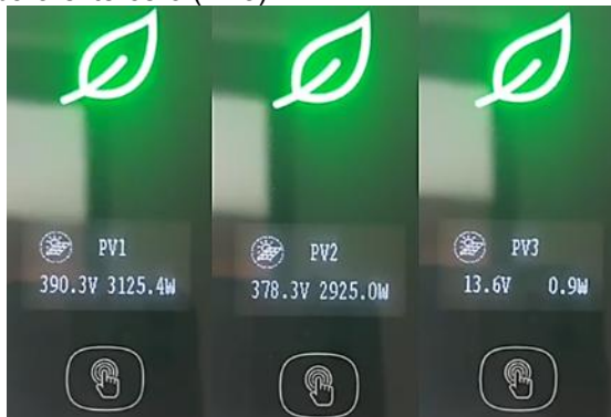
Imagen 9. Energía entregada por cada circuito de paneles.
