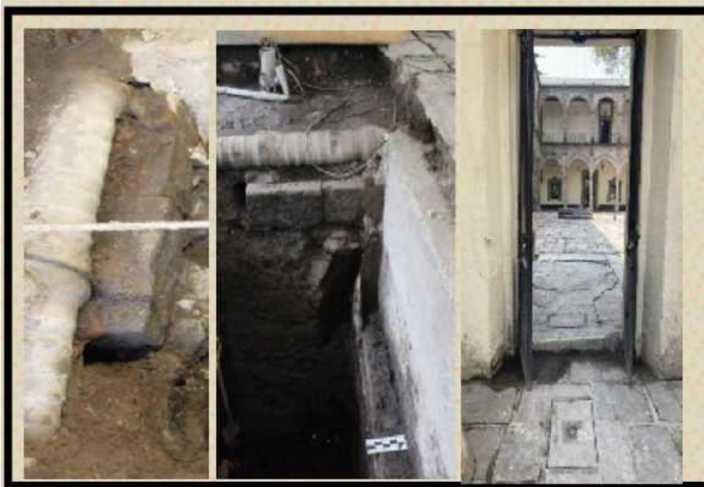
Figura 5. Vistas de la tubería moderna a lo largo de todo el patio de los cedros; por las coladeras de los registros conocemos la dirección que sigue y sabemos que esta tubería se conecta a otras, en el patio trasero, al parecer bajo la fuente que se observa al fondo de la imagen. Imágenes CCC-DSA, INAH, julio 2024.
