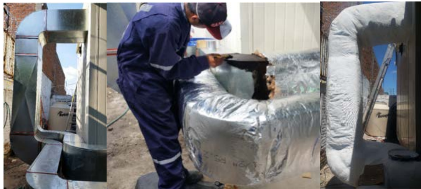
Ilustración 4 – 6. Proceso de impermeabilización de ductos. Ductos desnudos (izquierda), ducto cubierto con lana mineral (centro) y ducto con malla de refuerzo e impermeabilizante (derecha).
