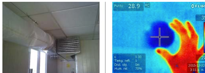
Ilustración 11. Termografía del recinto acondicionado después de 30 minutos de accionar el sistema GeoAire
