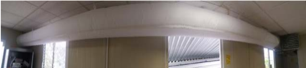
Ilustración 7. Vista panorámica del ducto textil instalado en el sistema GeoAire
