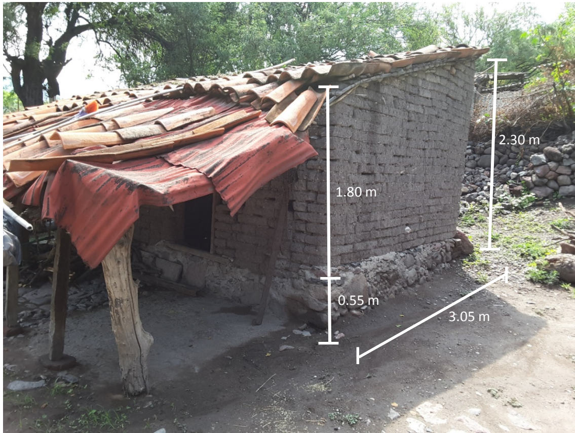
Figura 3. Vivienda tipo de adobe de la cual se tomaron las dimensiones para la vivienda analizada en el presente trabajo.
