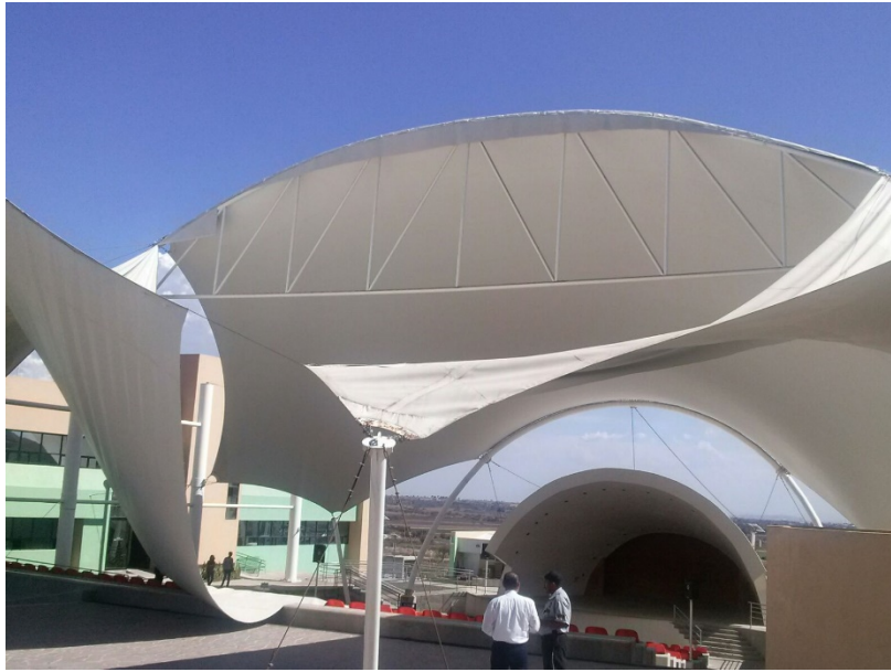
Figura 6. Ruptura de membrana tras ventisca similar a la simulación numérica
